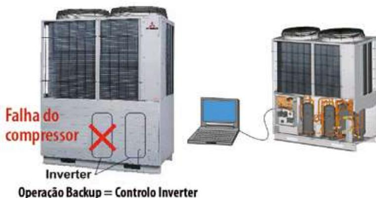
A operação de backup assegura o funcionamento do sistema em caso de avaria num dos compressores.
