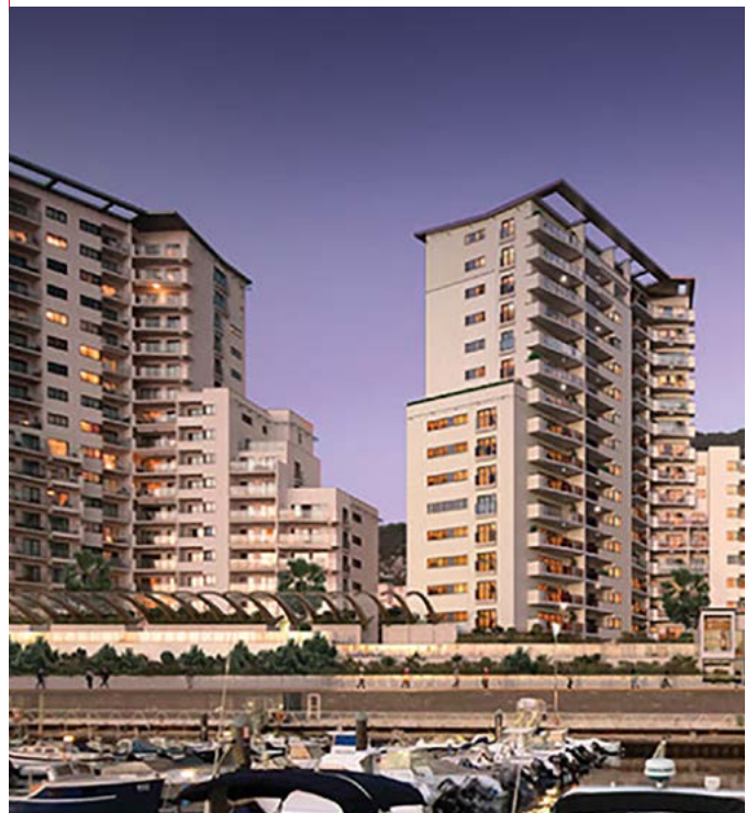
Torre KINGS WHARF (Gibraltar) Sistema instalado: Q-TON Bomba de calor com CO 2
