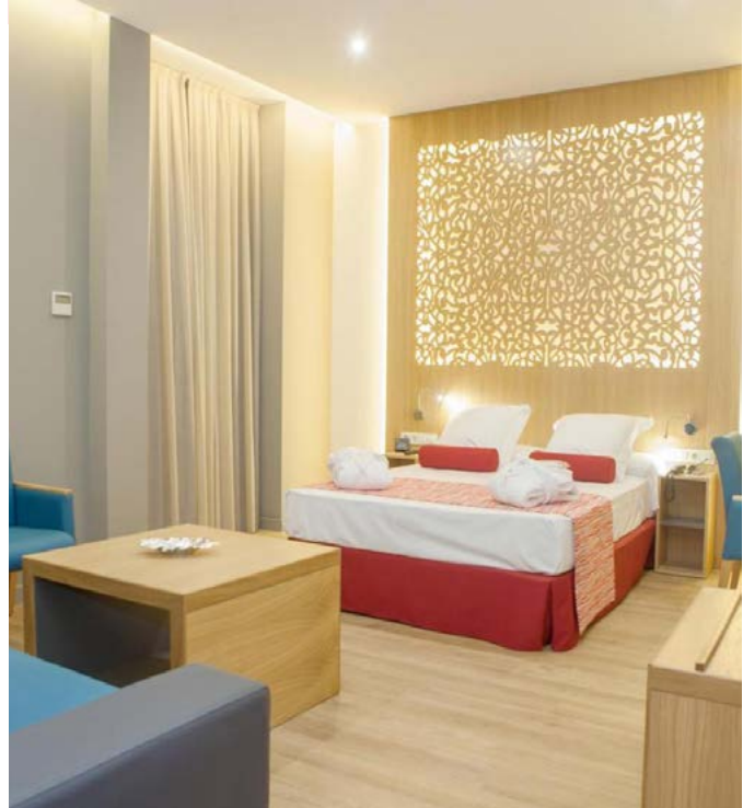
Hotel Soho Boutique Córdoba (Córdoba) Sistema instalado: Q-TON Bomba de calor com CO 2
