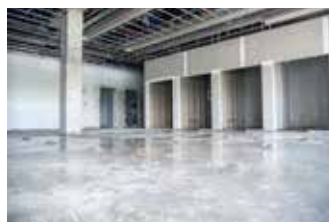
Estaleiros de obras
